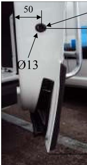
Percer Ø13 puis placer un passe fil sur le chant de la porte pour le passage de la tringle latérale.
