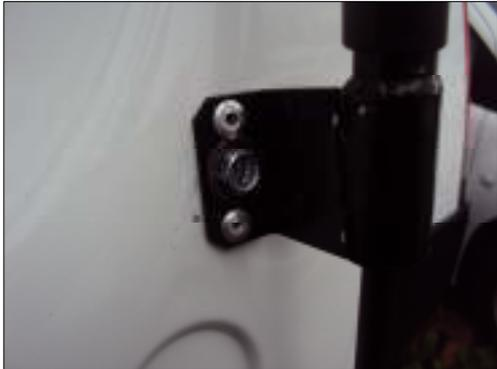
Fixer le guide tringle avec une vis M6 et deux rivets pop.
