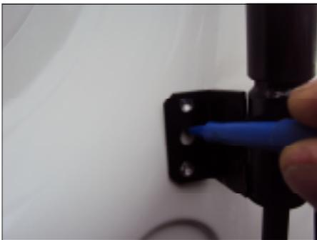
Tracer puis percer  $\varnothing 10$  le guide tringle Bas et placer un insert M6
