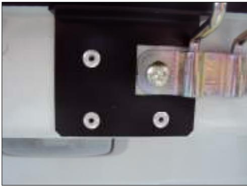
Mettre en place la gâche haute en la fixant par trois rivets pop.
